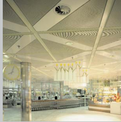
Migros Kloten, Dralldiffusor RA
