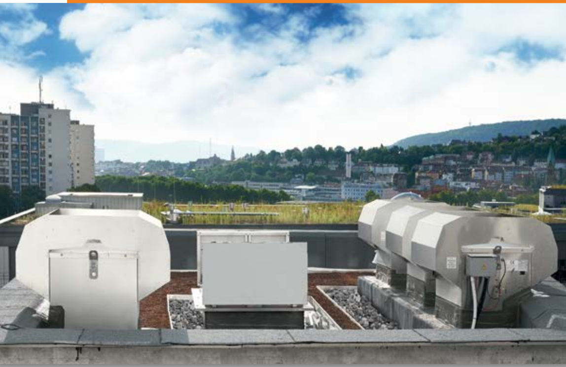
Mit Sicherheit effizient: Der axiale Entrauchungsventilator BVDAX kann über Frequenzumrichter geregelt werden und verfügt über ein komplett wärmedämmtes Gehäuse, das die Gebäudehülle dicht abschließt.
