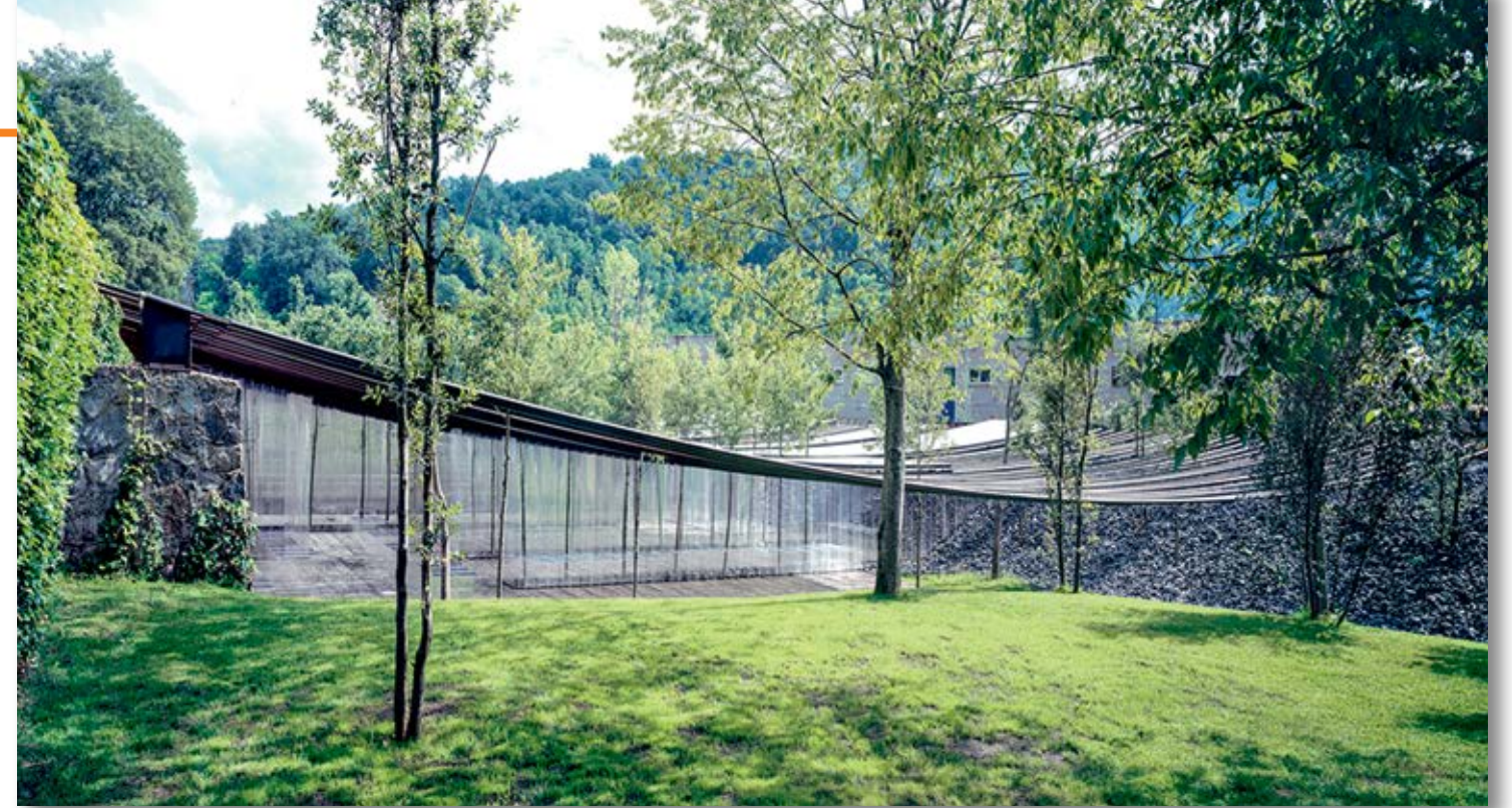
Freifläche für das Restaurant Les Cols, Olot
