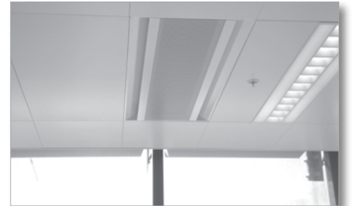
Deckeninduktionsdurchlass DID
