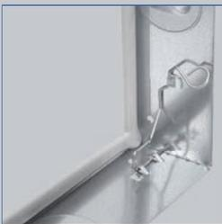
Spannelemente und Endlos-Dichtung
