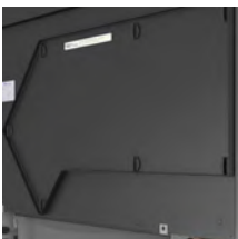
Revisionsdeckel Filter und Wärmerückgewinner
