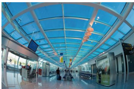
Brésil: TROX diffuseurs à jet hélicoïdal de distribuer l'air frais dans les salles et les couloirs de l'aéroport Santos de Rio de Janeiro Dumont.
